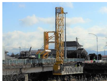
橋梁点検車を使用した点検 (一般県道 瀬峰豊里線 千貫橋)
