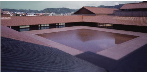
▲③島根県芸術文化センター（グラントワ）外観写真
