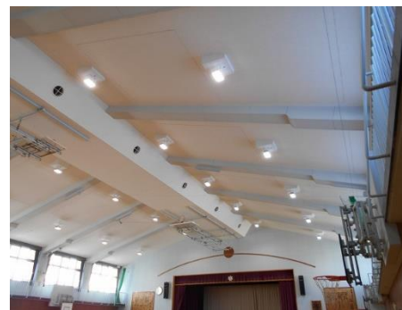
体育館照明のLED化
