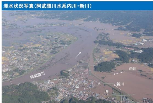
令和元年東日本台風による浸水状況（国土地理院撮影）
