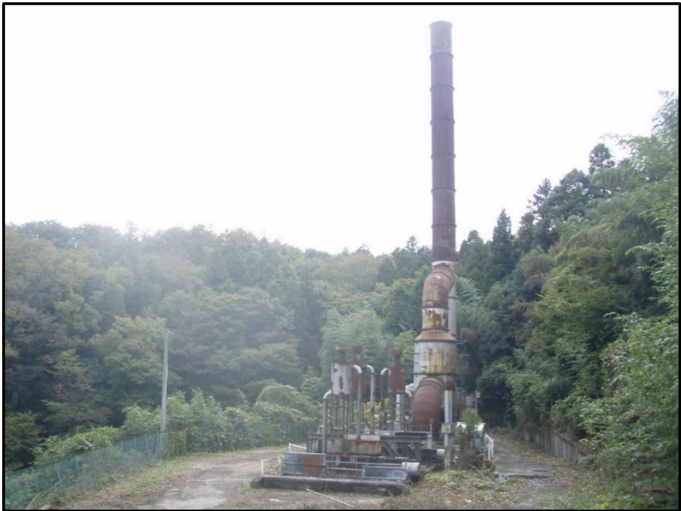
解体撤去する焼却施設本体
