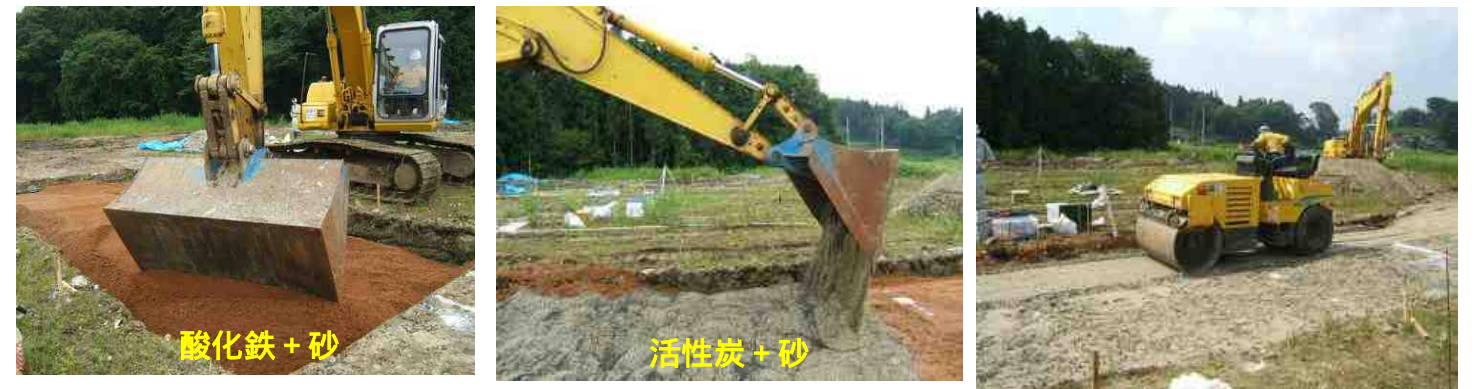
(1) 捕捉層1の敷均し (2) 捕捉層2の敷均し (3) 捕捉層の転圧締め（振動ロー） 多機能性覆土の捕捉層の施工状況（写真は試験施工状況）
