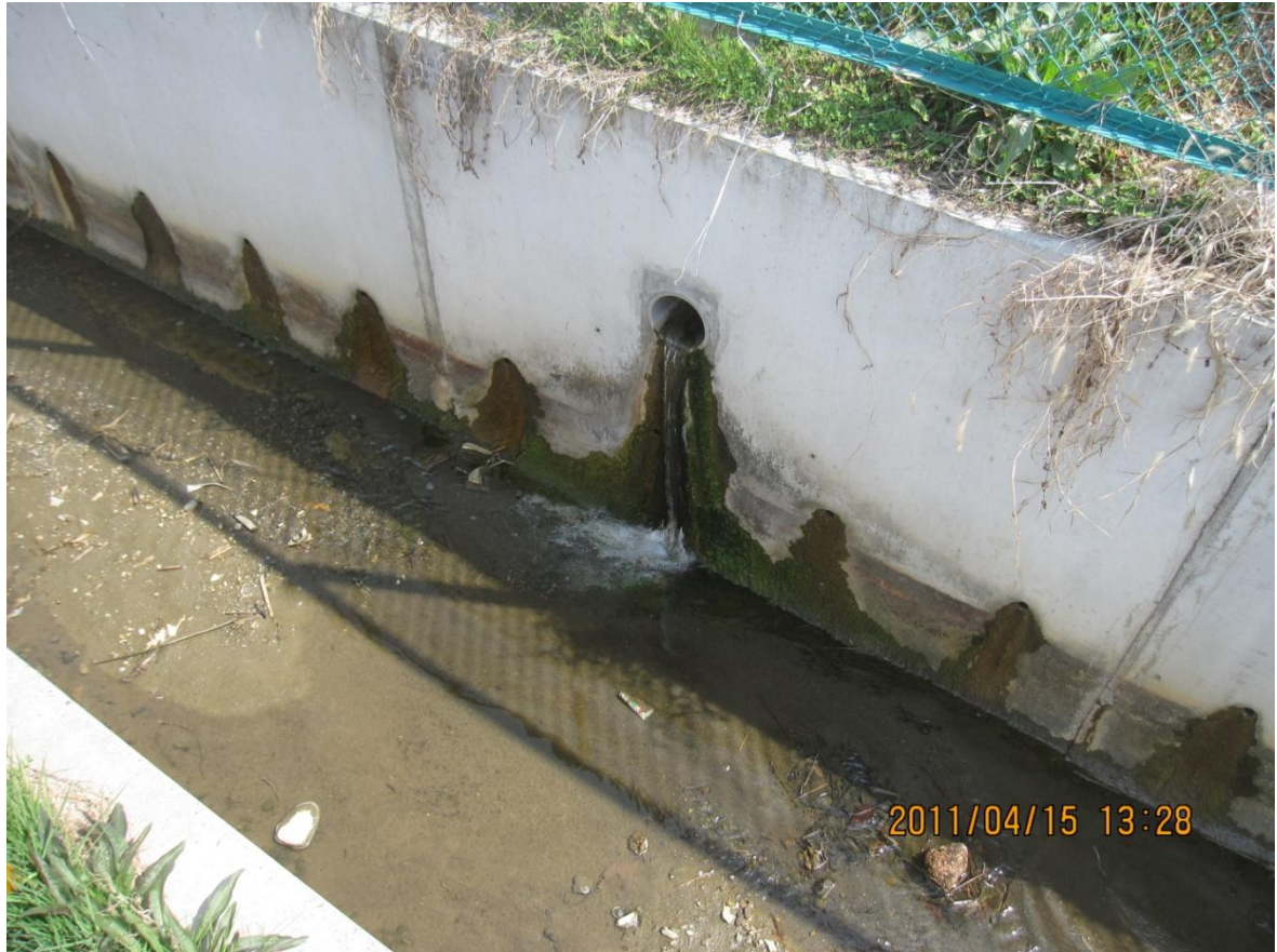
⑧ 放流水路脇の暗渠排水
