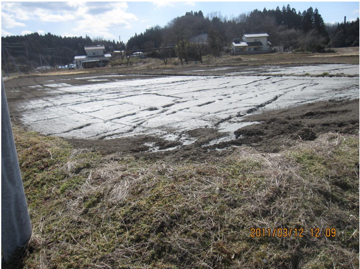
⑦-2 水田の液状化（処分場入口脇）
