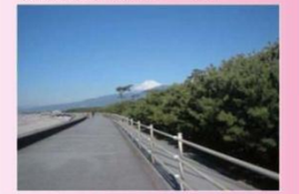
▲津波の被害を抑えるため、防潮堤を整備
