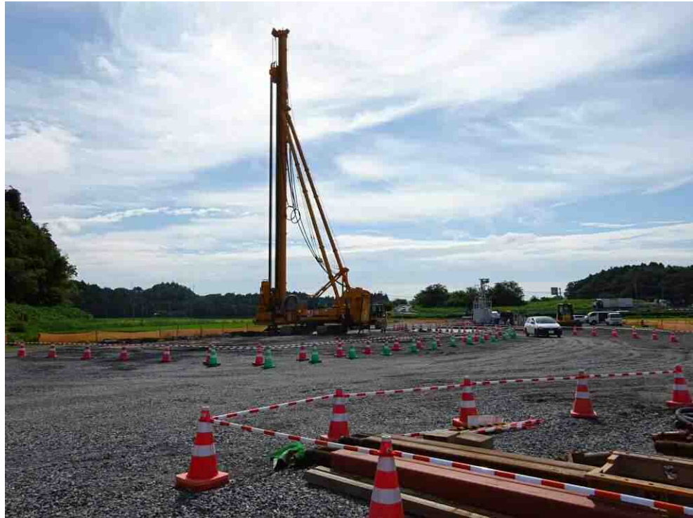
IV期終点部 軟弱地盤対策工施工状況
