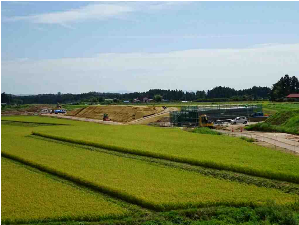
起点部：盛土工・函渠工実施状況
