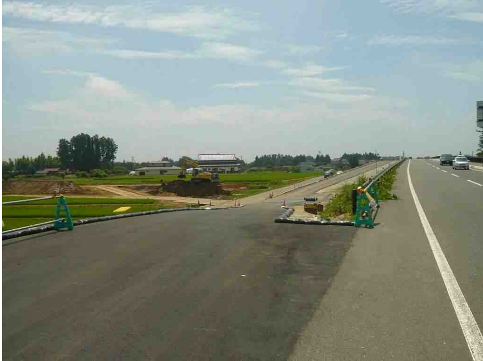
起点部：現道（国道4号築館バイパス）接続部
