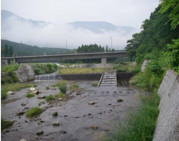
流路工整備状況(県道沼倉-鳴子線八幡橋:保全対象)
