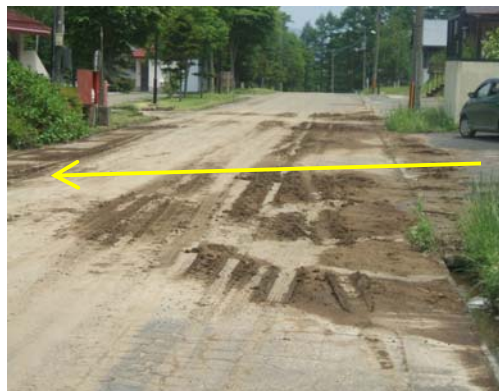
上流市道への土砂流出 (H19.6大雨後)
