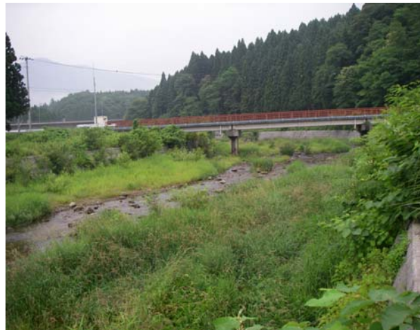
流路工整備状況(市道小向線小向橋:保全対象)
