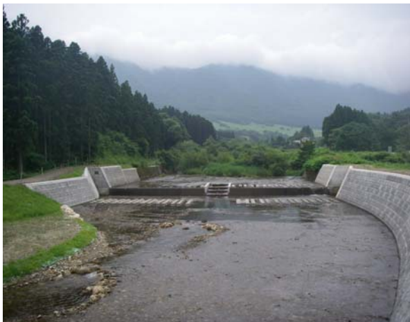
流路工整備状況
