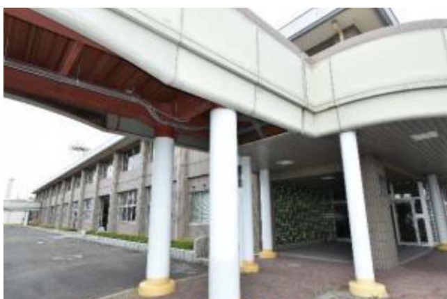
④ 4号館実習棟（運動場側から撮影）
