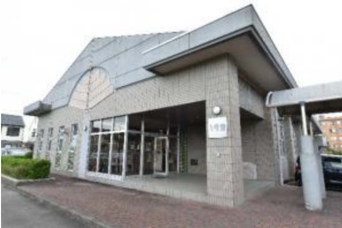
① 1号館実習棟（運動場側から撮影）
