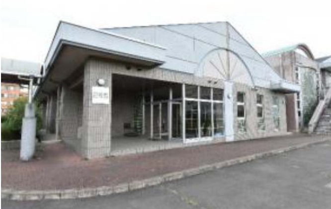
② 2号館実習棟（運動場側から撮影）
