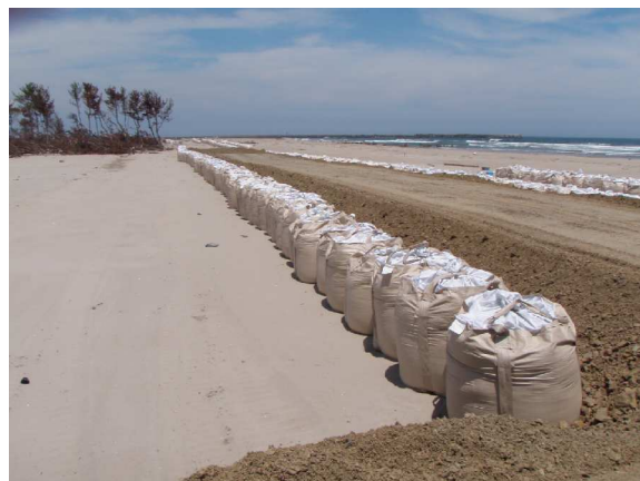
荒浜漁港海岸応急工事施工状況
