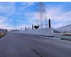
【漂流物対策施設】 津波漂流物対策設置工事（その7）
