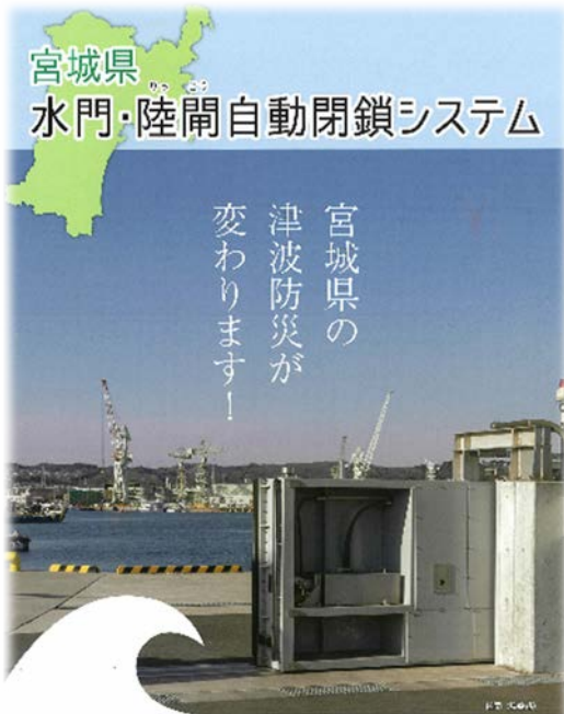
宮城県は、通信ネットワークにより水門・陸閘を自動で閉鎖し、津波被害を軽減する取り組みを進めています。安全かつ迅速・確実な津波防災を実現するために、水門・陸閘を閉鎖して被害を軽減する取り組みを進めています。津波注意報・津波警報・高潮警報が発令されたら、迅速かつ安全に水門・陸閘を閉鎖して被害を軽減してください。
