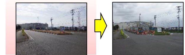
津波漂流物対策設置工事(その6) [着手前] [施工中]
