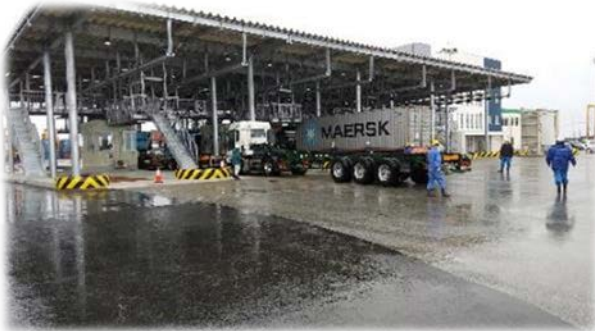
◎新トラックゲート(8レーン)
