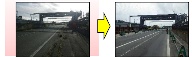
貞山通(A)胸壁外災害復旧工事(その4) [着手前] [施工中]
