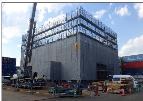
管理棟新築工事(施工中)
