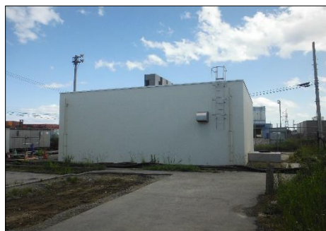
第一受変電室新築工事(完成)
