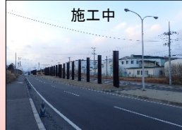
津波漂流物対策施設設置工事（仙台市宮城野区港一丁目（蒲生幹線）） ◎延長ベース（平成30年3月末）
