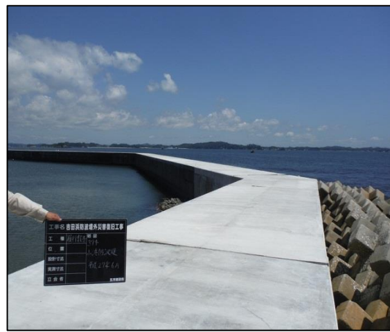
防波堤施工完了(H27年6月)
