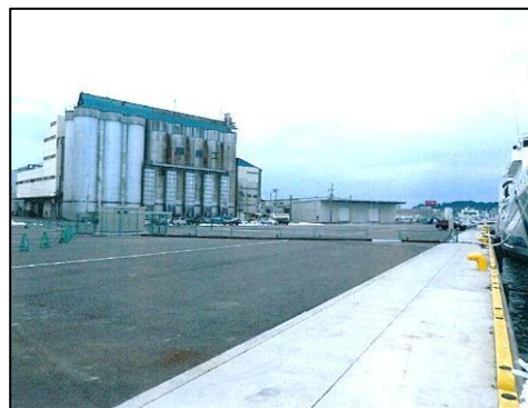
舗装工事完了(H27年3月)
