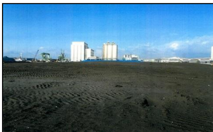
舗装工着工前(H26年12月)
