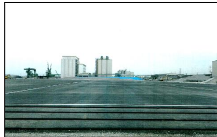
舗装工完了(H27年5月)
