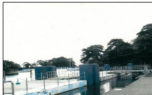
浮さん橋工事・据付完了(H27年3月)
