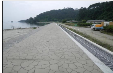
護岸施工完了(H27年7月)
