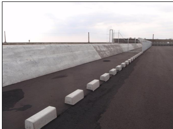
● 工事が完了した高砂南防波護岸
