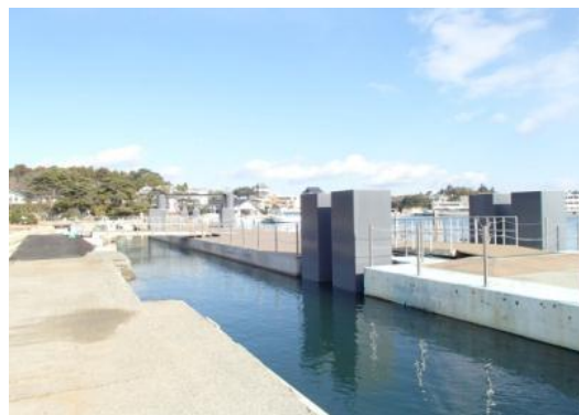
●工事が完了した海岸前浮さん橋
