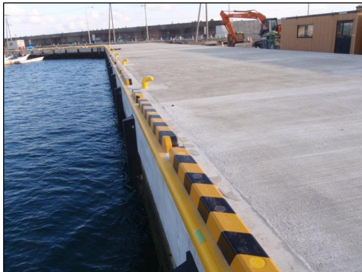
● 工事が完了した高砂船溜まり
