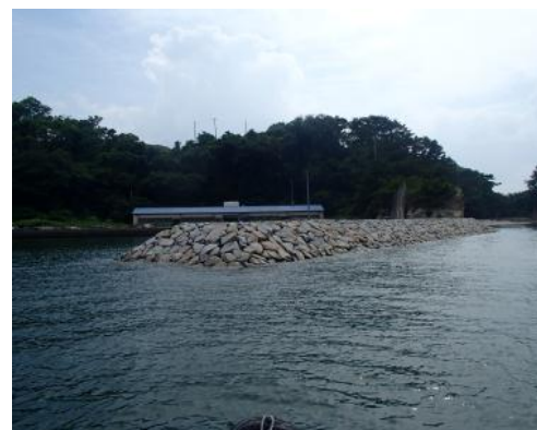
●工事が完了した桂島スリス浜防波堤
