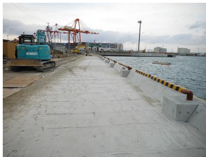
●高砂船溜り物揚場の災害復旧工事
