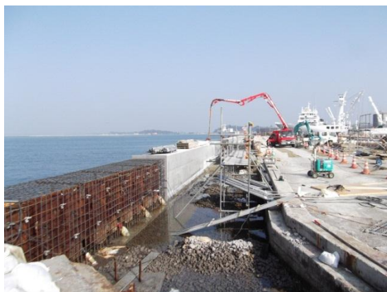
● 中ふ頭前面護岸の災害復旧工事
