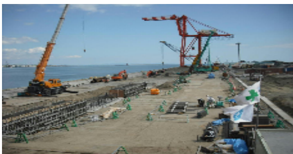
●高砂コンテナターミナル復旧工事
