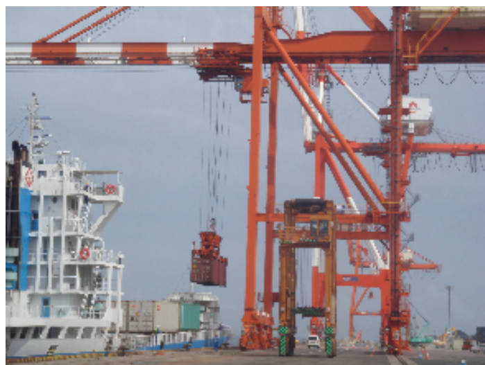
●復旧したガントリークレーン2号機
