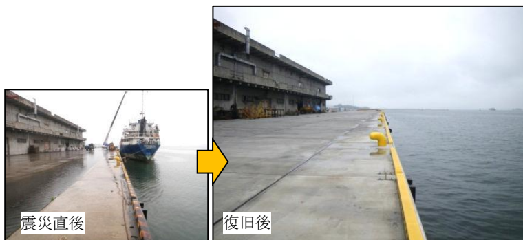
○貞山ふ頭2号岸壁
