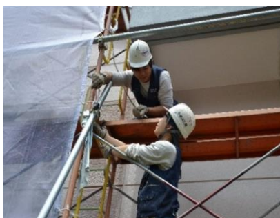
足場実習 (足場組立作業)
