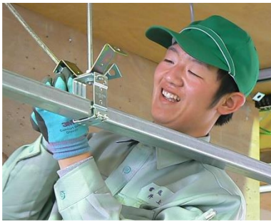
レースウェイ取付実習
