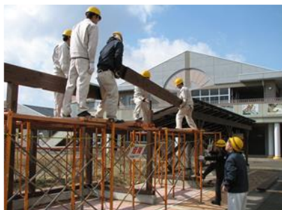
応用設計製作実習 (木造軸組施工実習)
