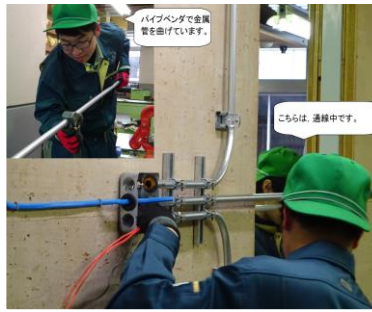
金属管工事实習
