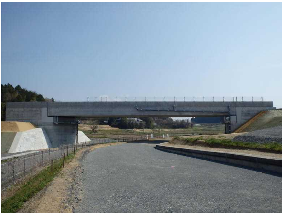
萩沢前2号橋 施工状況
