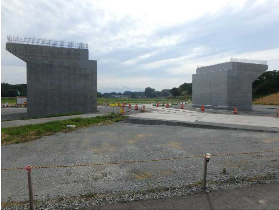
萩沢前1号橋 施工状況
