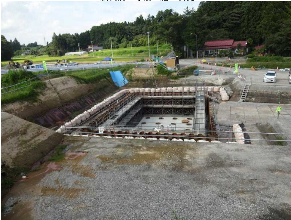
萩沢忽滑沢本線橋 下部工 施工状況
