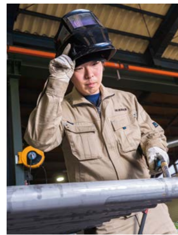
雲梯に使うパイプを溶接する
