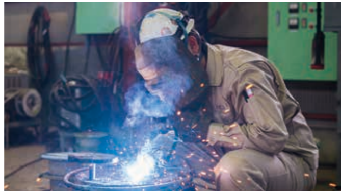
溶接して金属同士をつなぎ合わせる
