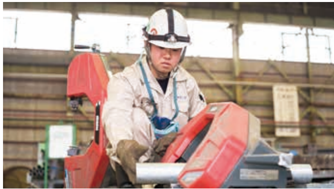
配管を機械でカットして長さを微調整する
