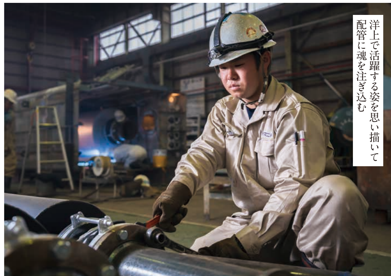
2本の配管の接合部分をボルトで固定する櫻井汰生さん
