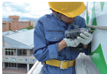
訓練では高所作業も行う。仙台校の屋上にある看板の製作・取り付けは、広告看板科の訓練生が担当している
