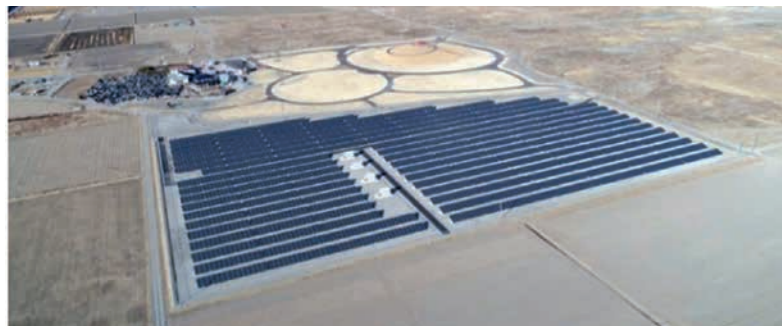
「亙理・山元第2地区」太陽光発電所
