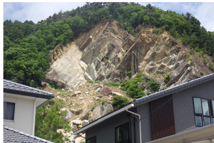
石巻市垂水山(急傾斜地崩壊)
