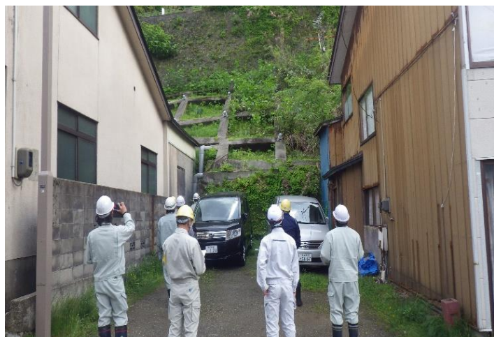
大崎市湯元(急傾斜地崩壊)
