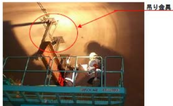
写真- 4.1.3 触診作業状況
