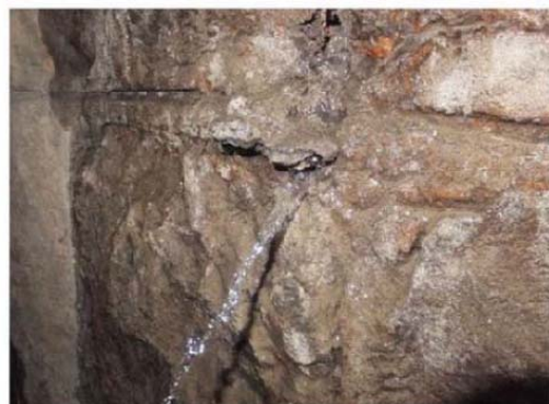
写真- 4.3。7 漏水（噴出）している例
