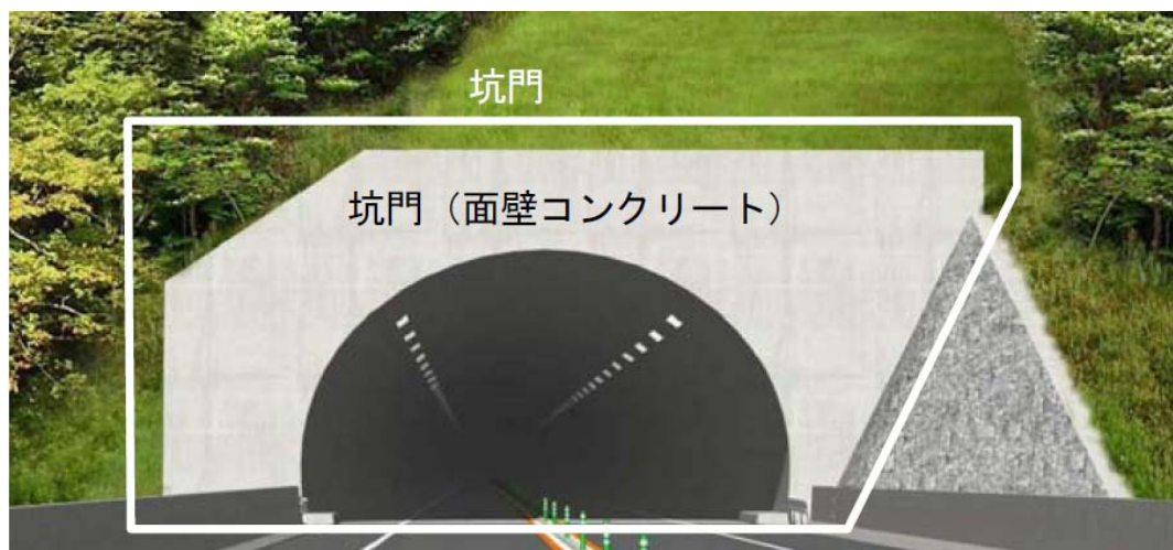
図- 4.2。2 点検対象箇所（トンネル坑口部）
