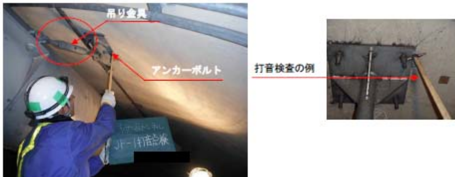
写真- 4.1.2 打音調査作業状況
