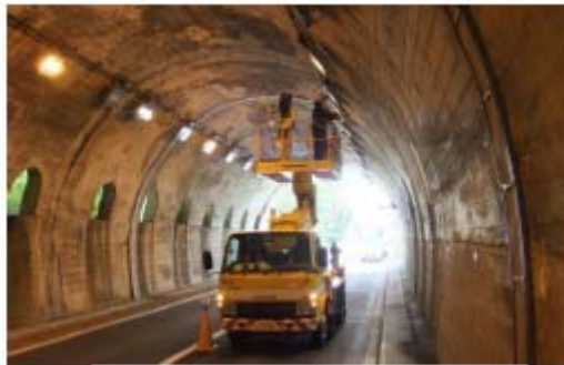
写真- 4.1。1 近接目視作業状況
