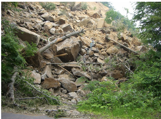
(主) 県道築館栗駒公園線
