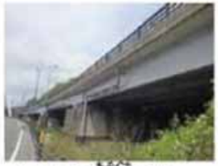
写真-4 阿蘇口大橋 (国道57号)
