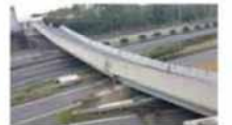
写真-1 奥道小川高島線 府領第一橋
