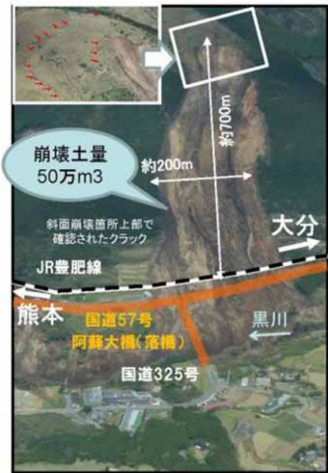
写真-5 斜面崩落と阿蘇大橋の落橋 (国道57号・国道325号)
