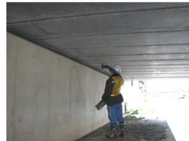
定期点検の状況
