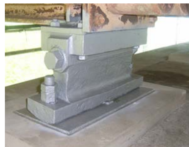
鋼製支承の金属溶射
