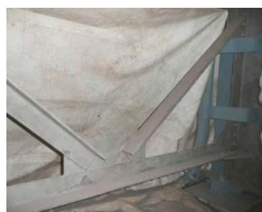
桁端部の重防食塗装
