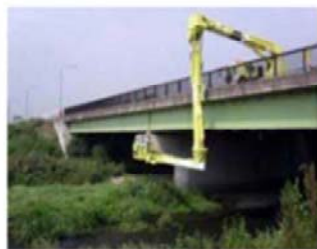
橋を定期的に点検し、痛み具合を調べます(5年に1回)。
