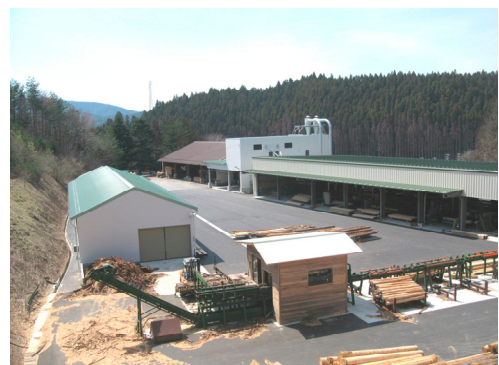
写真－9 復旧した製材工場(南三陸町)
