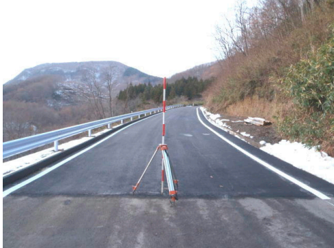
写真－5 復旧した林道(大和町)
