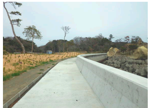
写真－7 復旧した海岸防潮堤(東松島市)
