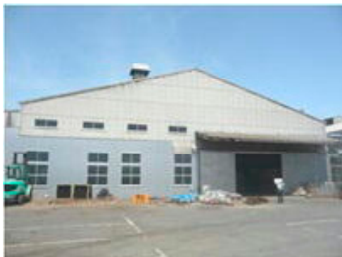
写真－8 復旧した合板工場(石巻市)
