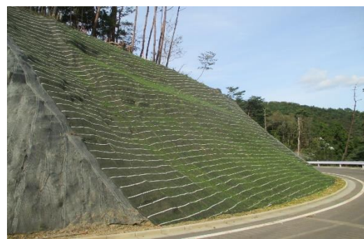
林道施設災害復旧事業実施箇所
