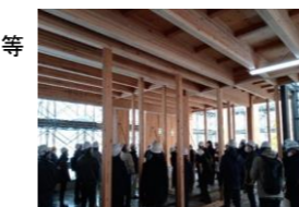
CLT施工講習会
