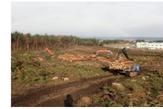
一貫作業現場の状況
