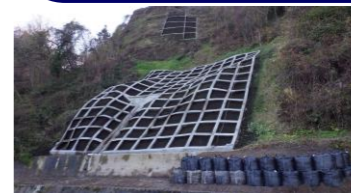
山腹崩壊の復旧(大崎市)
