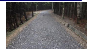
林道施設の復旧(石巻市)
