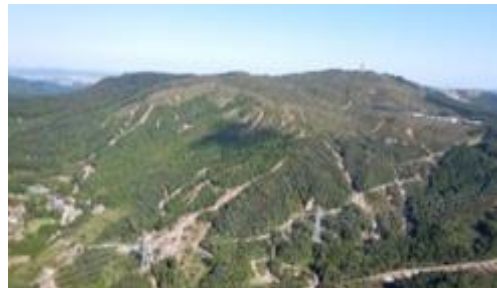
未曾有の大雨による山腹崩壊（丸森町子安地区）
