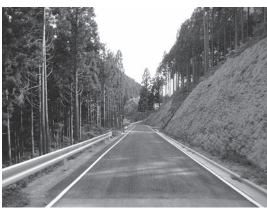
もうすぐ開通する林道「登米東和線」
