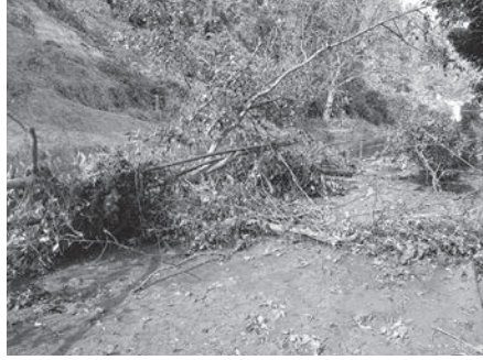
土砂流出により 通行止めとなった遊歩道
