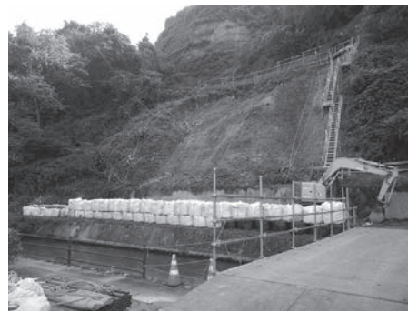
復旧工事が進む法面
