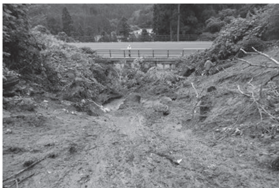
平成30年大雨により発生した山腹崩壊により土砂が国道まで流出した「大崎市柳木地区」
