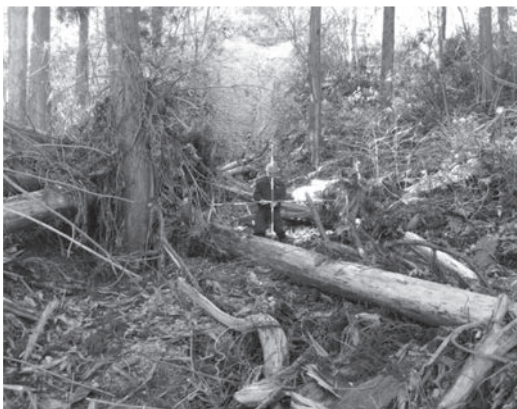
緊急対策計画区域「大崎市尾ヶ沢地区」
