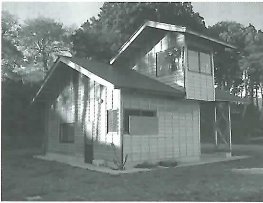
施設の全景(東日本大震災後)
