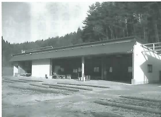
新設された建屋
