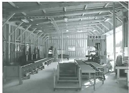
建屋内の製材機
