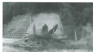
(被災直後の状況)
