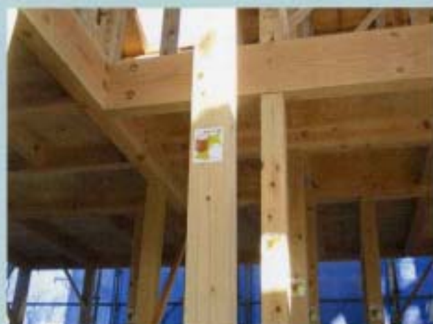
認証材を使った住宅建築現場
