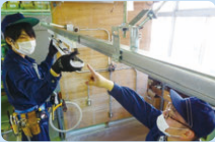
レースウェイ(金属線び)配線工事及びLED照明取り付け工事。
