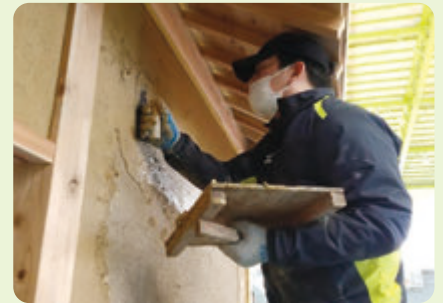
上棟後は、土壁塗りも含めた内部仕上げを施し、本格的な茶室内部をつくります。
