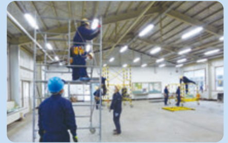
ローリングタワーの組立て作業(足場の組立て等特別教育)
