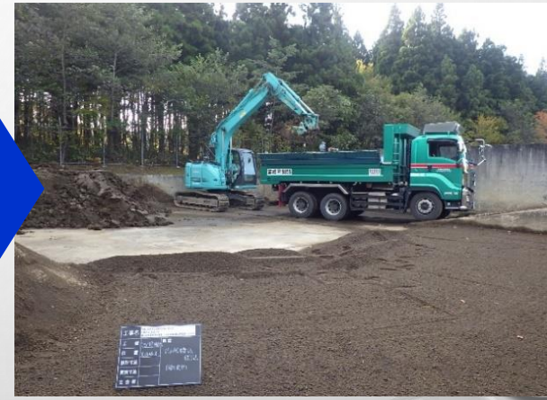
ダンプトラックへ積みこみ (処分場(しょぶんじょう) へ運ばれます。)
