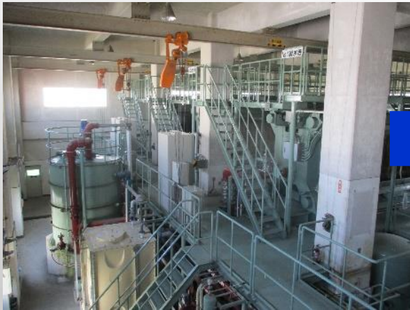
だっすいき 脱水機 (泥水(どろみず)から 水分を取りのぞきます)
