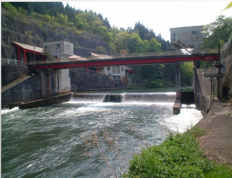
かどさわしゅすいぜき 門沢取水堰
