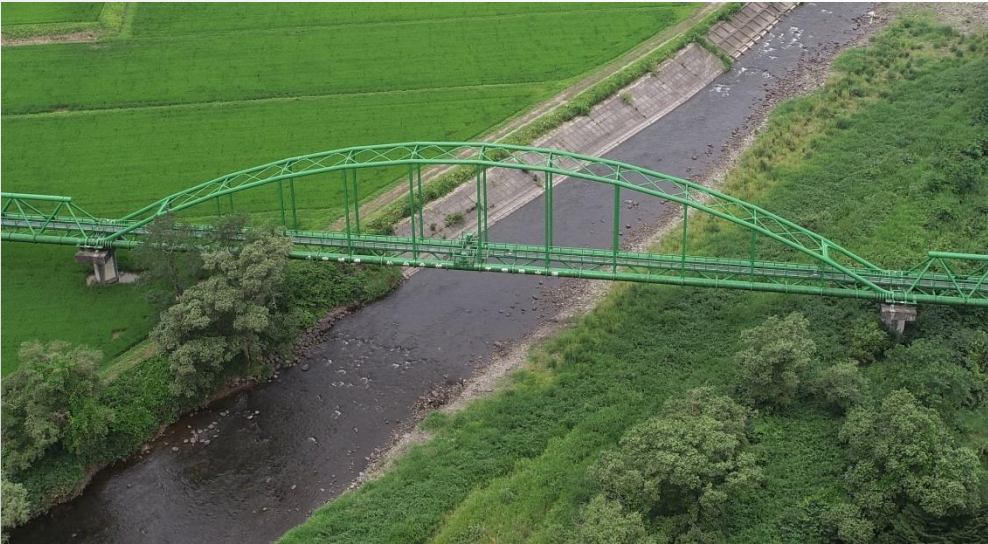
すいかんきょう 水管橋
