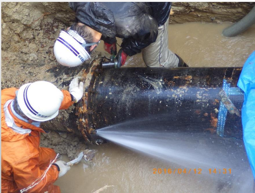
管からの漏水(ろうすい)の様子
