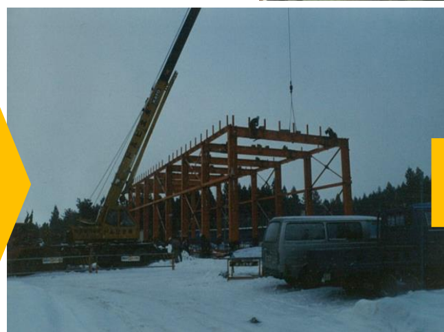
建屋工事の状況
