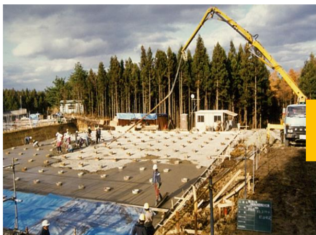
土木工事の状況
