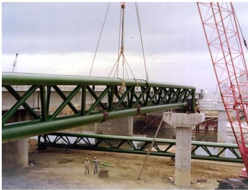
土手前水管橋施工状況(昭和52年度当時)
