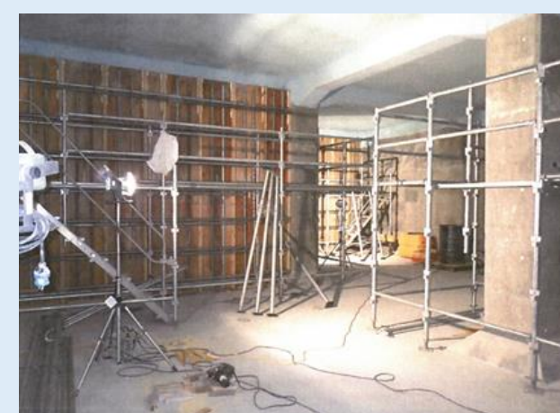
調整池の耐震化工事
