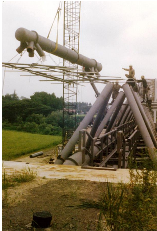
掃出水管橋施工状況(昭和53年度当時)
