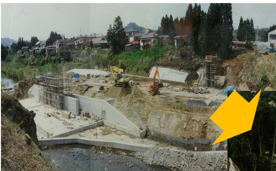
取水堰工事中(平成5年当時)
