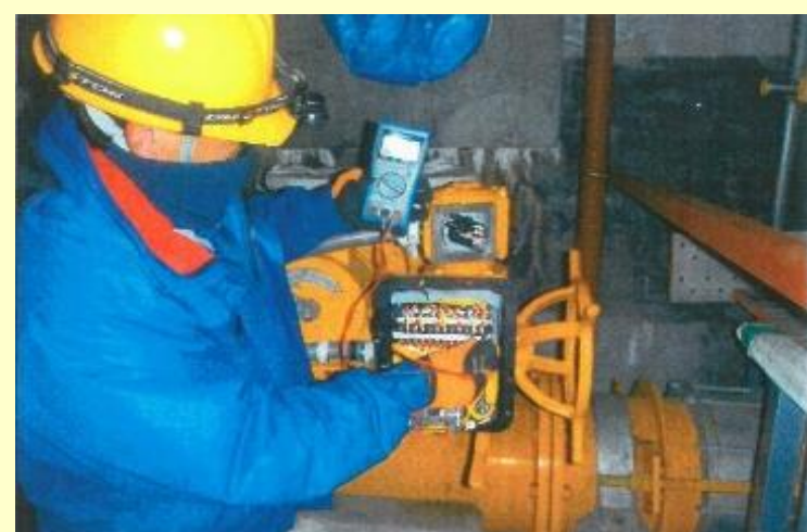
ろ過池表洗弁修繕
