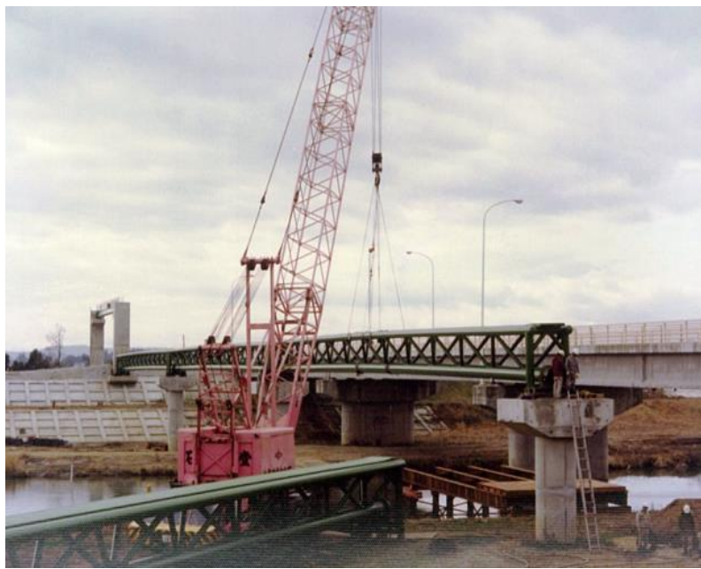
土手前水管橋施工状況(昭和52年度当時)
