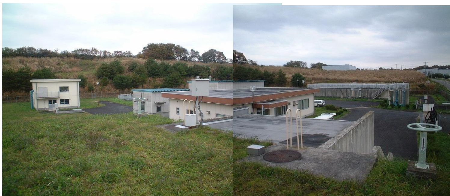
現在の衡東浄水場全景
