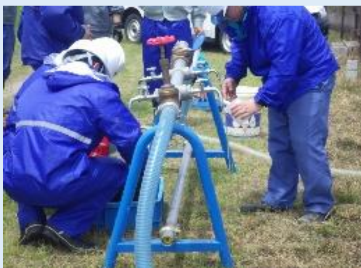
緊急給水システム設置訓練
