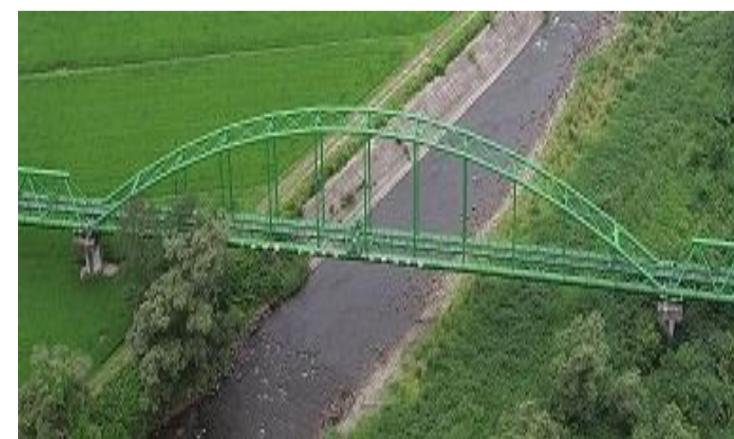
ランガー型式(掃出水管橋)
