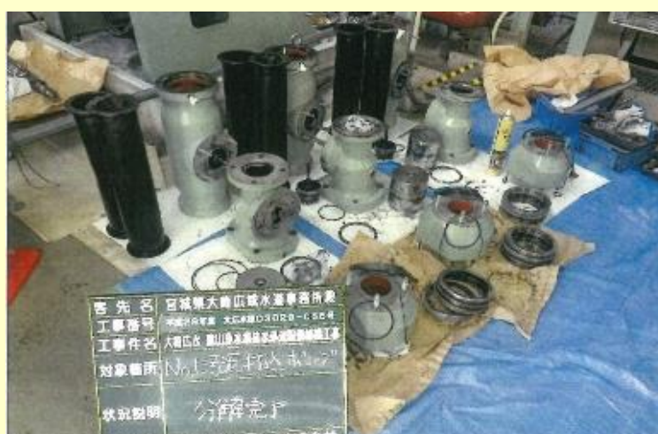
汚泥打込みポンプ修繕
