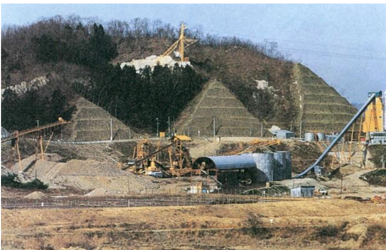
ダム工事中(昭和58年当時)
