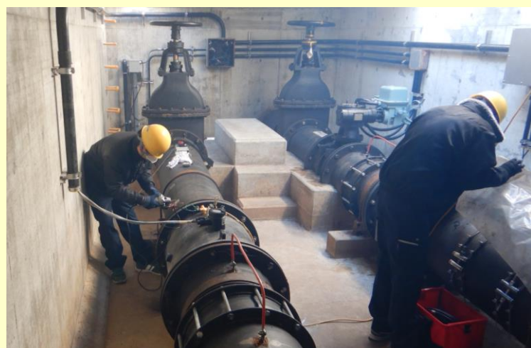
配水流量計修繕
