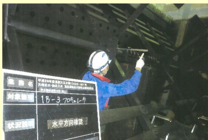
浄水機械設備点検
