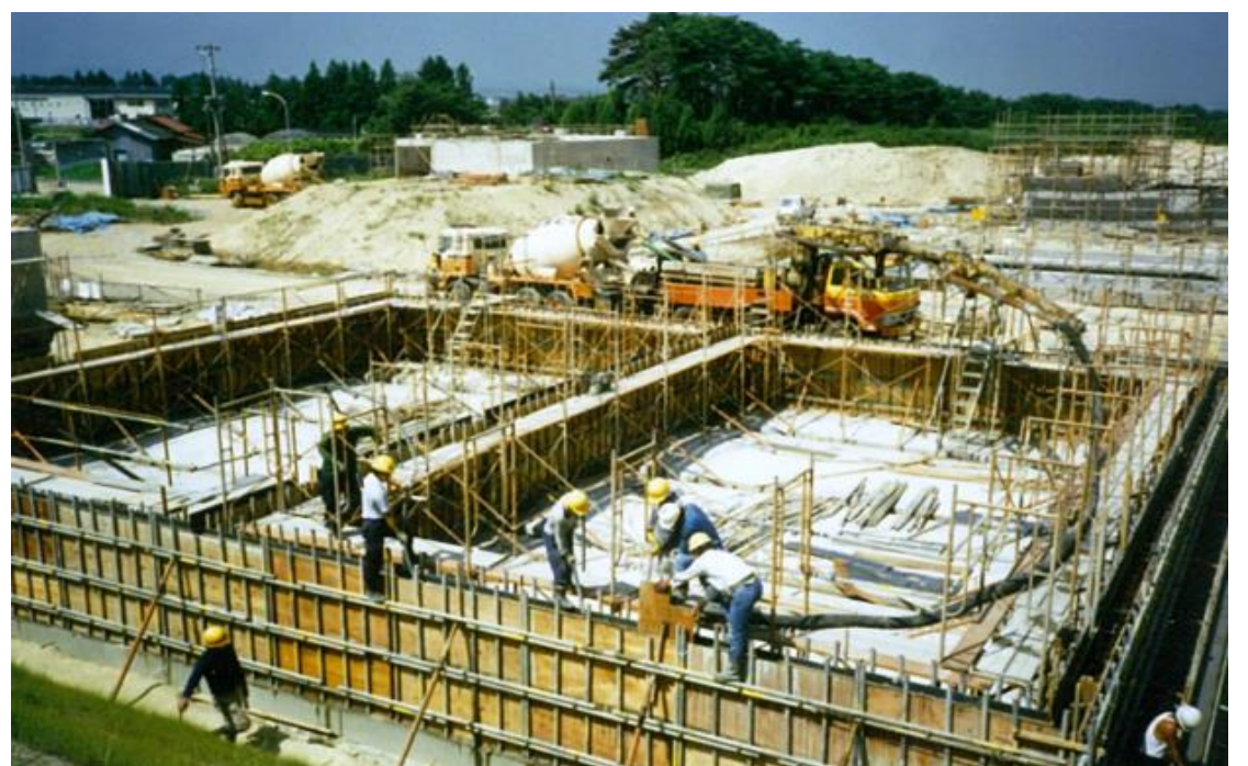
天日乾燥床のコンクリート打設状況(昭和60年当時)
