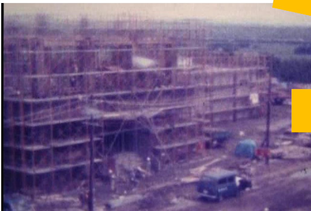
管理本館建築工事中(昭和52年当時)
