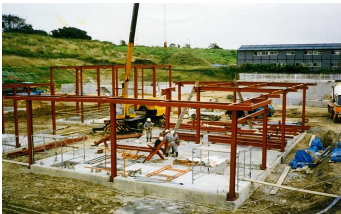
管理棟鉄骨工事の状況(昭和60年当時)
