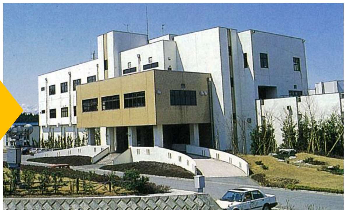
管理本館完成(昭和53年5月)
