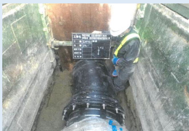
管路の耐震化工事
