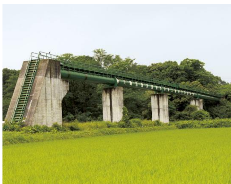
大滝川水管橋
