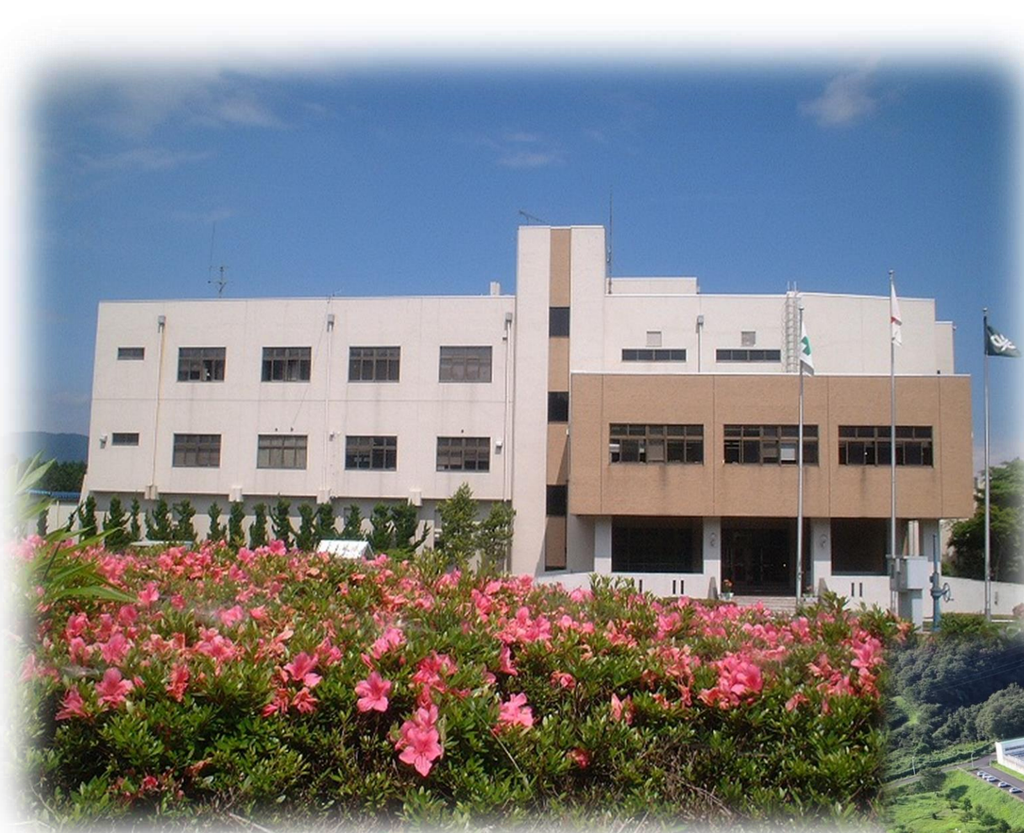
大崎広域水道事務所(麓山浄水場(加美町))
