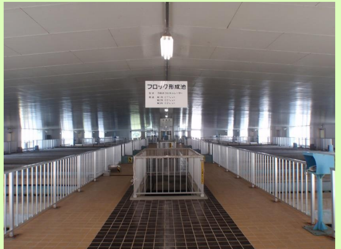
浄水施設内部(現在)
