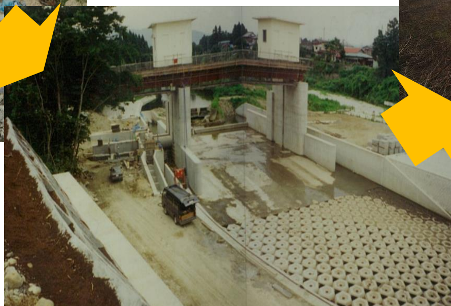
取水堰工事中(平成6年当時)
