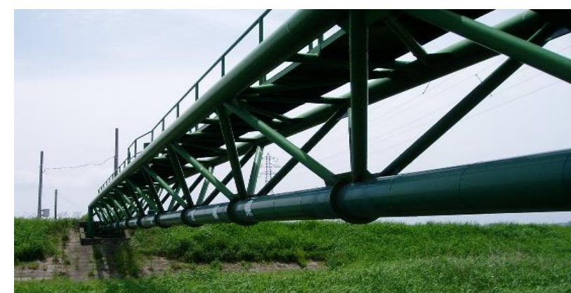
逆三角トラス型式(和多田沼水管橋)
