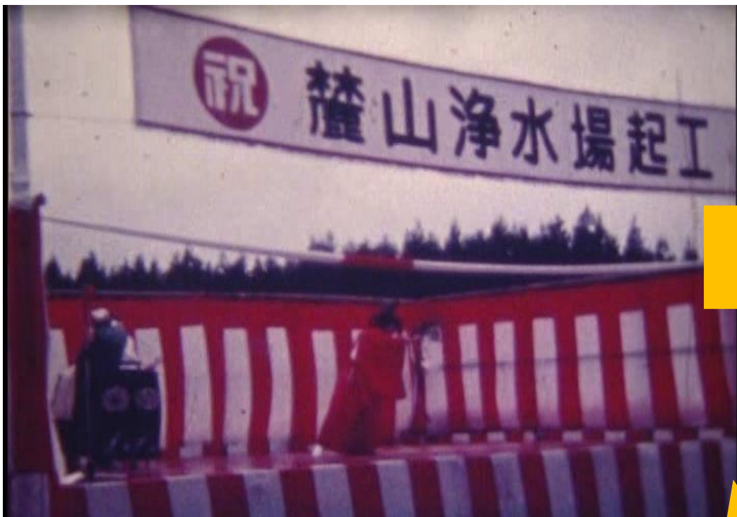
麓山浄水場起工式(昭和50年当時)
