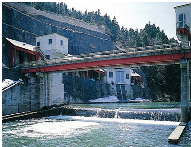
門沢取水堰(昭和52年度完成)
