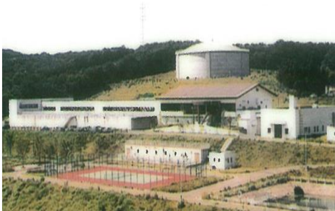
管理本館など施設棟の完成状況
