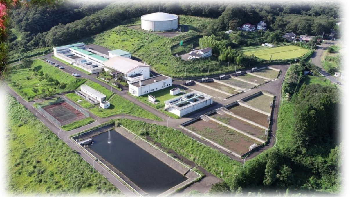
中峰浄水場(大和町)
