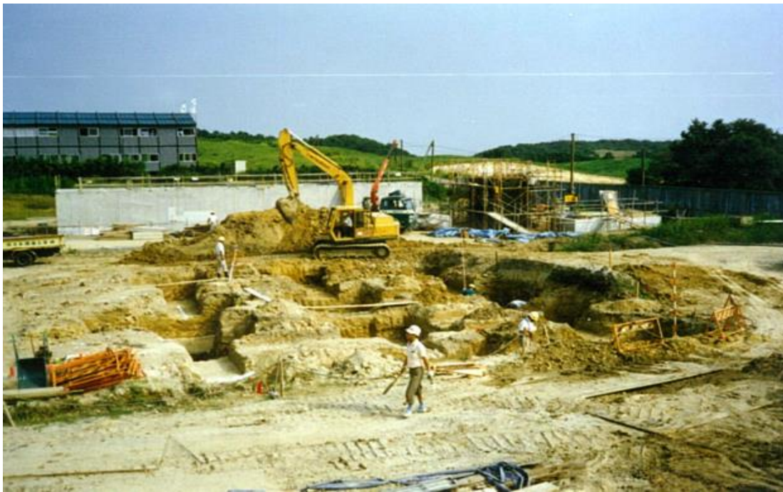
造成工事の状況(昭和60年当時)
