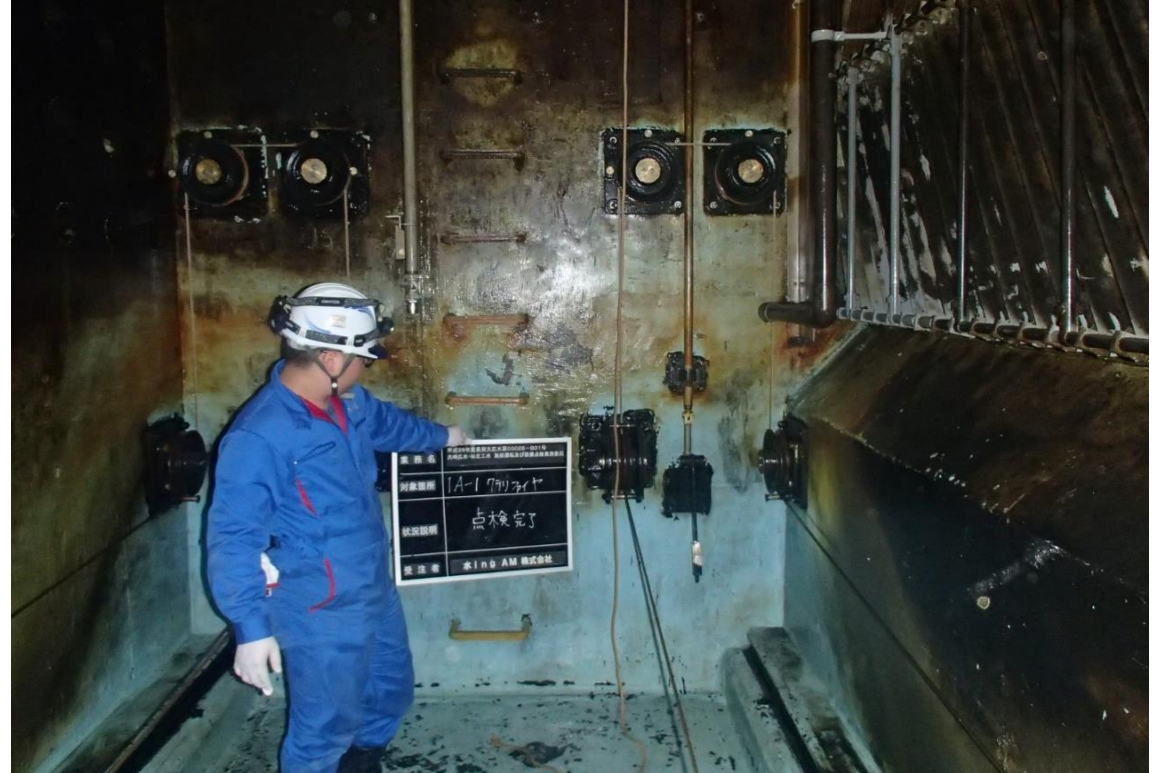
設備の点検状況
