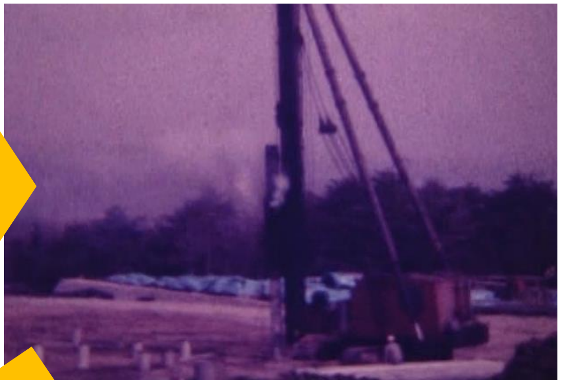
管理本館基礎杭施工中(昭和51年当時)
