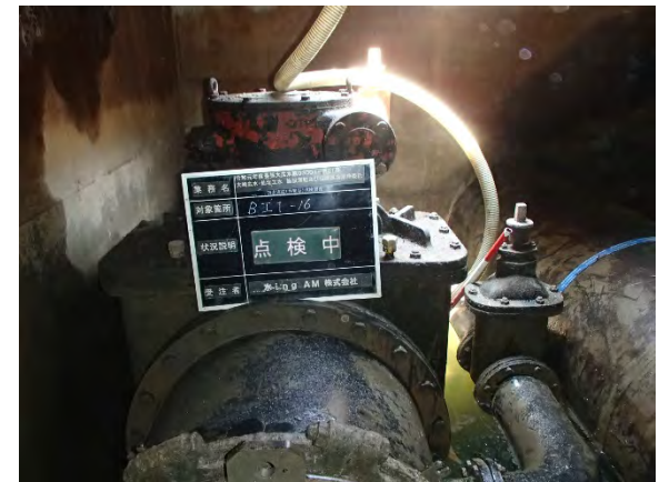
制水弁点検状況
