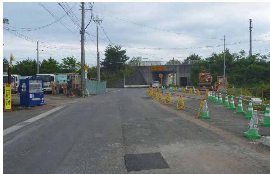
舗装復旧箇所
