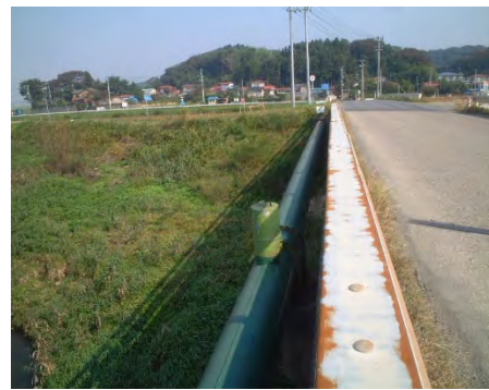
田尻川水管橋工区
