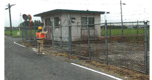
幹線テレメータ室の巡視状況
