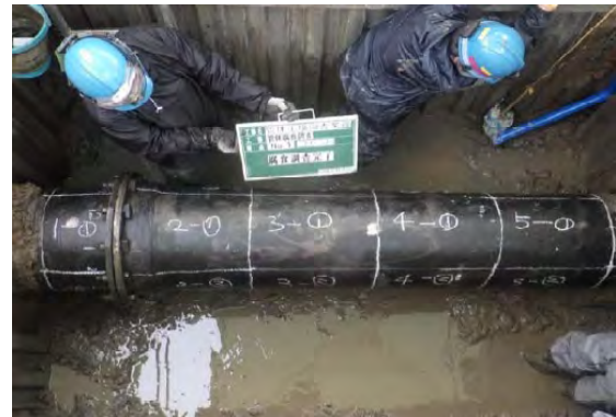
管体の腐食劣化調査の状況
