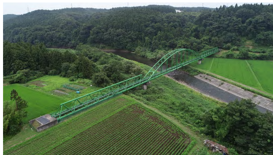
掃出水管橋全景
