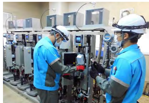
設備点検状況
