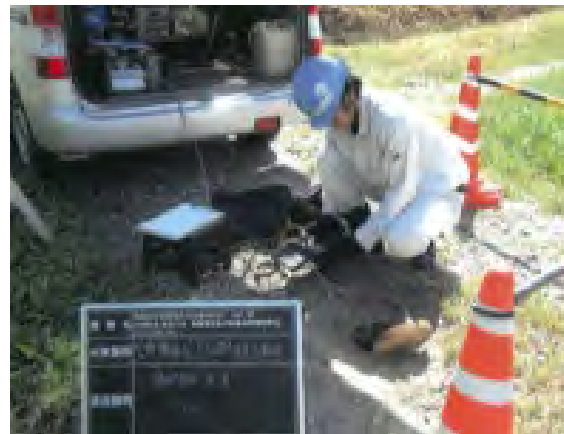
電気防食設備点検状況
