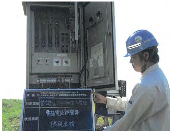
電気防食設備点検状況
