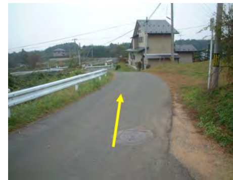
三本木枝線工区
