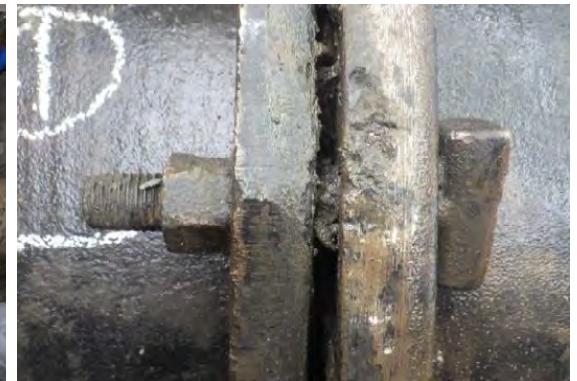
管継手部のボルト等の状況
